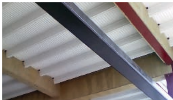
Set nedefra: Brandisolerede stålbjælker bærer trapezpladen, som betonen er udstøbt ovenpå.
