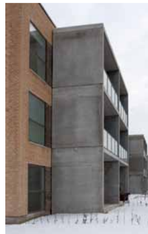
En iøjnefaldende detalje ved byggeriet er altanelementerne i beton, som er monteret uden på selve huset.
