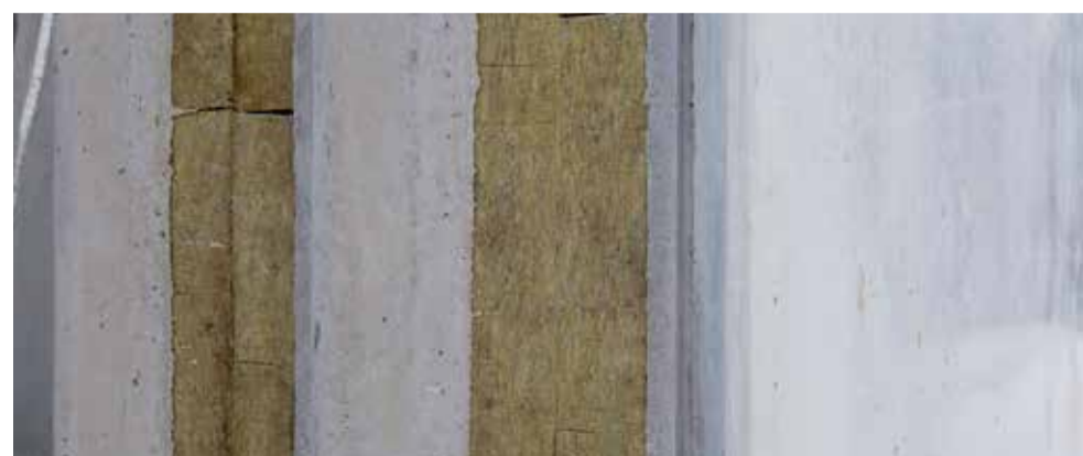
Eksempel på elementtykkelse med mineraluld-isolering
