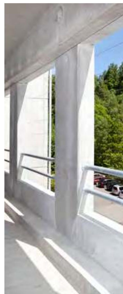
P-hus, Vejle Sygehus.
