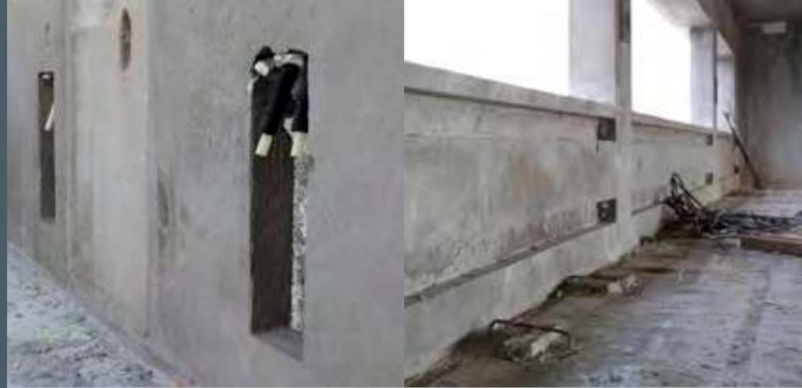
Kabler til solafskærmning, vand- og varmerør samt el indstøbes i elementerne.
