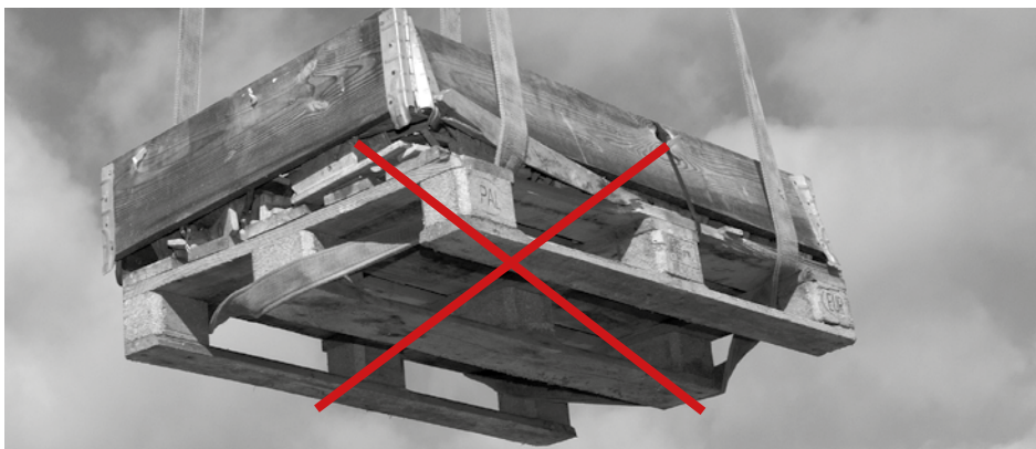
Ovenstående billede viser hvor farligt et palleløft med stropper kan være.
