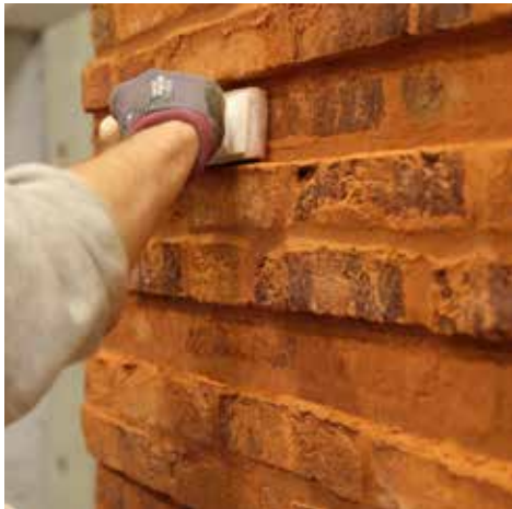
Murværket afrenses umiddelbart efter opmuring.
