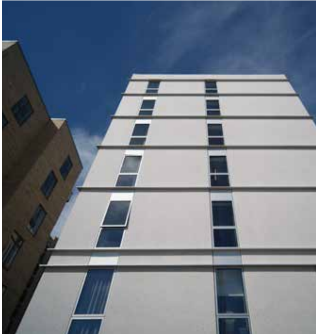
ZLEEP HOTEL COPENHAGEN ARENA, KØBENHAVN Flotte hvide polerede sandwichfacader i dobbelt-højde og uden synlige fuger.
