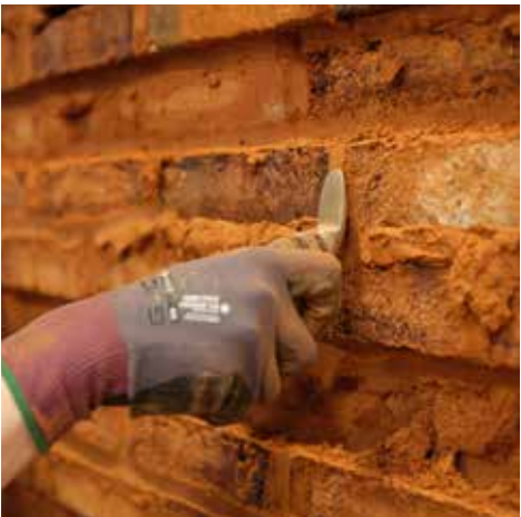
Håndværket er i højsæde, når fugerne trykkes.
