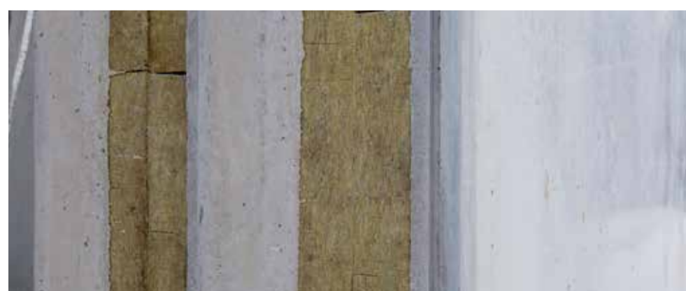
Eksempel på elementtykkelse med mineraluld-isolering
