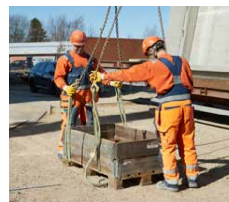
Et korrekt løft med stropper kræver 2 mand. Med PF kan 1 mand løfte opgaven.
